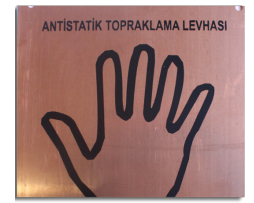
Antistatik Topraklama Levhası
